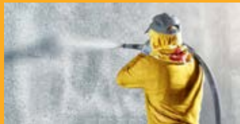
NAPRAWA I WZMACNIANIE KONSTRUKCJI
