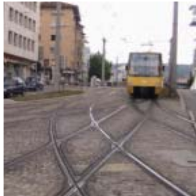
Stuttgart/Niemcy, Berliner Platz (rozjazd tramwajowy, szyna Ri60, podparcie ciągłe).
