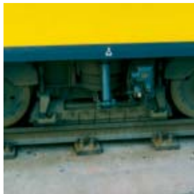
Berlin/Niemcy. Mocowanie punktowe podkładek materiałem Icosit® KC.
