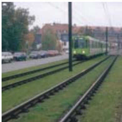
Hannover-Langenhagen/Niemcy. Mocowanie punktowe na belkach betonowych.
