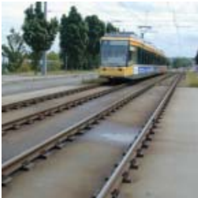
Karlsruhe/Niemcy, Most Siemens Allee. Podkładki Rph1 mocowane do podłoża jedynie materiałem Icosit® KC 340, bez dodatkowego mocowania mechanicznego.
