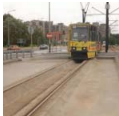
Kraków /Polska, wiadukt Izydora Stella-Sawickiego. Szyna Ri60 w pełni zatopiona w materiale Icosit® KC 340/45.
