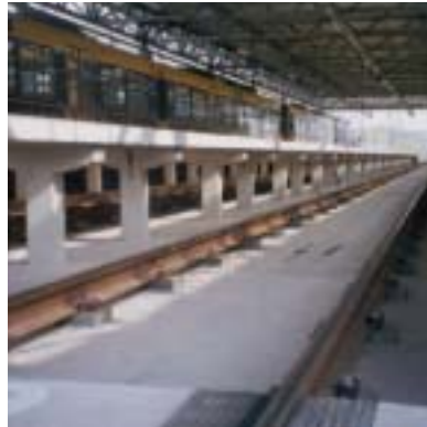
Remseck/Niemcy; zajezdnia lekkich pociągów kolei podmiejskiej SSB. W celu zmniejszenia kosztów, podkładki stalowe zamocowano materiałem Icosit® KC 340 bez dodatkowego kotwienia mechanicznego.
