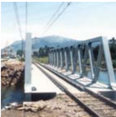
La Pereda/Hiszpania; F.E.R.V.E., most kolejowy. Po podparciu szyny UIC 54 materiałem Icosit® KC, znacząco zmniejszony został hałas związany z użytkowaniem torowiska.
