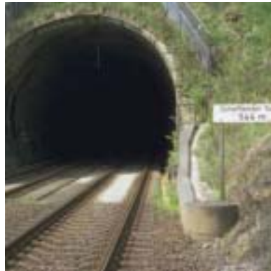
Mosbach/Niemcy; tunel kolejowy Schefflenzer. Mocowanie punktowe (wykonane zgodnie z normą DB Ioarb 199) na płycie podtorowej po usunięciu tłucznia w celu zwiększenia wysokości skrajni.
