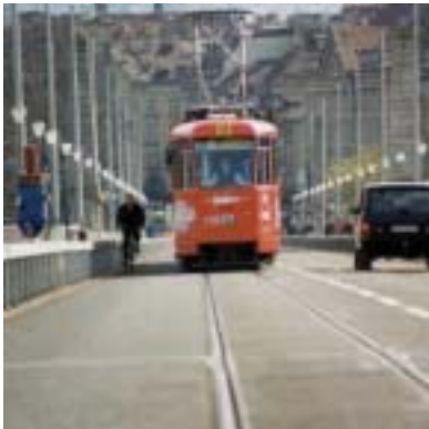
Berno, Szwajcaria, most Kornhaus. Ciągłe podparcie szyny (Ri51) materiałem Icosit® KC 340 umożliwiło obniżenie wysokości skrajni i znaczącą redukcję ciężaru torowiska na tym historycznym obiekcie.
