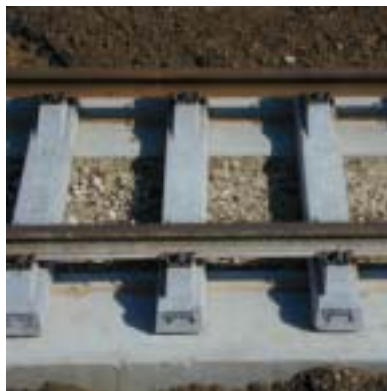
Stuttgart/Niemcy. Detale zielonego torowiska typu "Bremen" przed zasypaniem podkładów.
