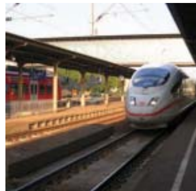
Göppingen/Niemcy. Mocowanie punktowe materiałem Icosit® KC 340 w ciągu toków szynowych kolei Intercity Express.
