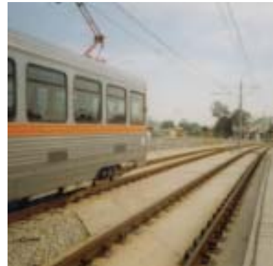
Lekki pociąg Tuen Mun /Hongkong. Mocowanie punktowe podkładek typu Pandrol materiałem Icosit® KC.
