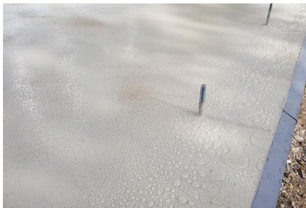
Doszczelnienie szpilek pod mocowanie balustrad
