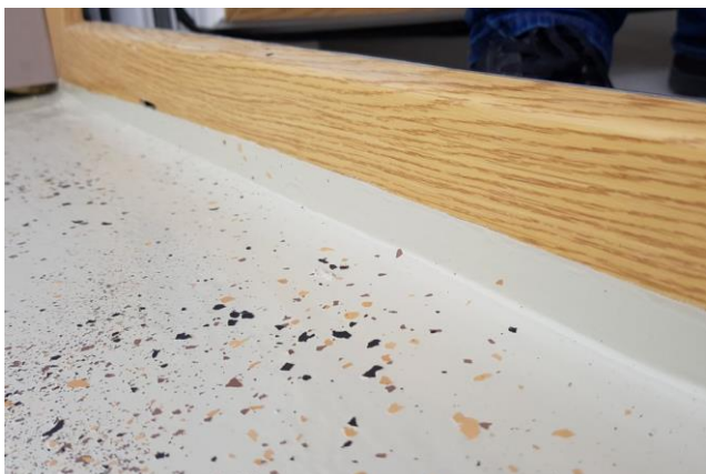
Doszczelnienie styku posadzka - okno balkonowe
