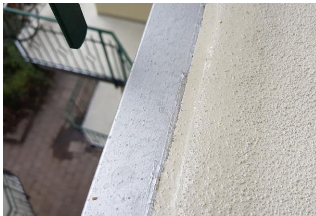
Doszczelnienie styku posadzka - obróbka blacharska
