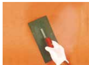
Zamykanie zasypki piaskowej zwykłą pacą z prostą krawędzią lub raklą
