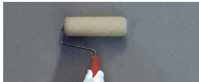
Aplikacja Sikafloor®-264 Thixo wałkiem strukturalnym.
