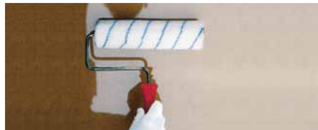
Nakładanie materiału gruntującego wałkiem ze średnim włosiem
